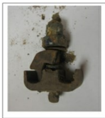
Gammal korroderad klämma
